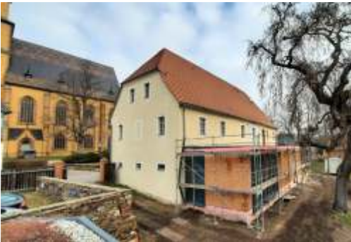
Blick auf den Neubau von Westen
