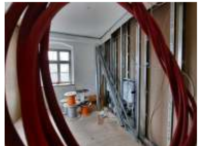
Trockenbau in der künftigen Kinderküche
