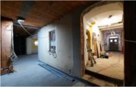
neuer Eingangsbereich und Übergang in den Altbau
