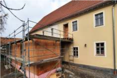
Blick zum neuen Haupteingang am Neubau
