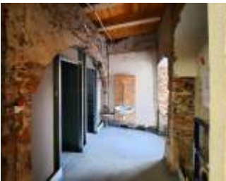
Toiletten im Erdgeschoss
